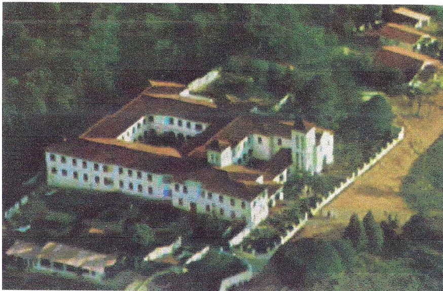
Vista aérea do mosteiro CICMST
